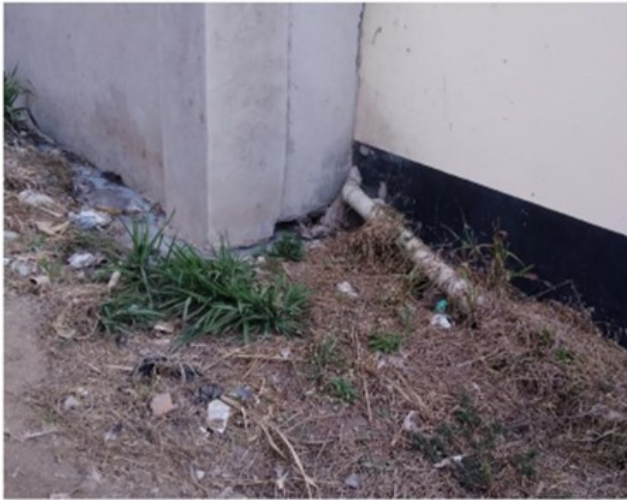
Toilet Soak way
